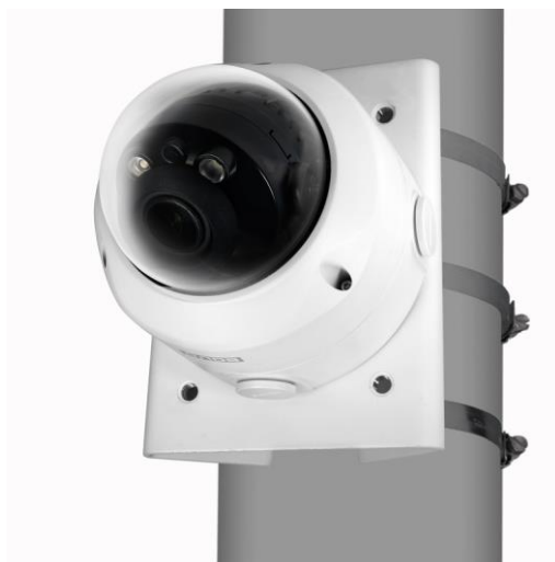
Рисунок 5.11 – Монтаж видеокамеры на столбовом кронштейне BR-103
